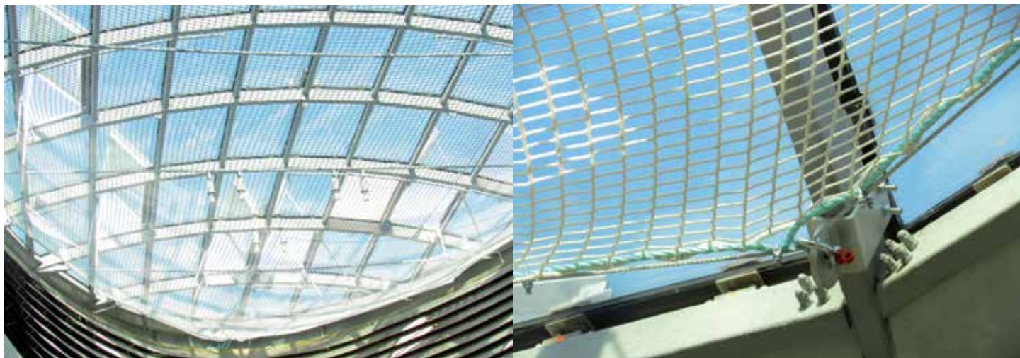
TN15 tirante di ancoraggio in poliestere, nastro bianco con riga arancio, altezza mm 35, lunghezza cm. 100 con asole da cm.15 alle estremità, carico di rottura 1800 kg. La rete nell'immagine è l'art. RS6
